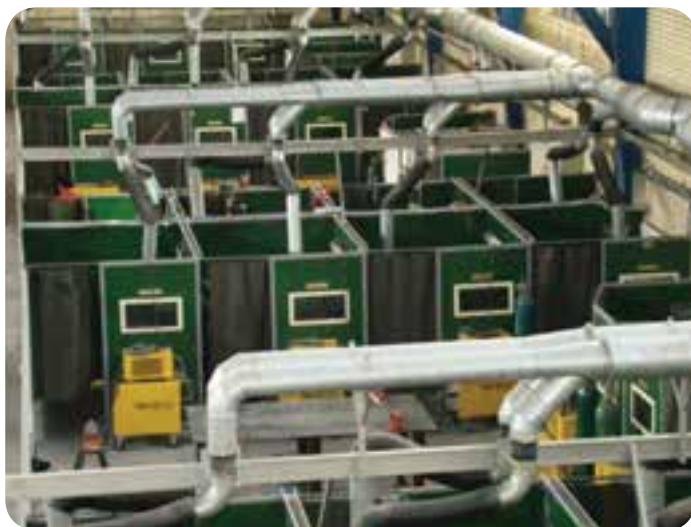
نمونه‌ای از سیستم تهویه موضعی در اتاق‌های مخصوص جوشکاری
