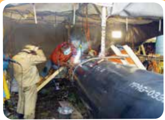
ن) کارگاه ساخت خط لوله
