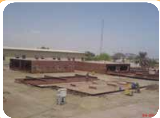
د) کارگاه ساخت اسکلت فلزی ساختمان
